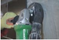
staubfreies Schleifen von Fliesenkleber
