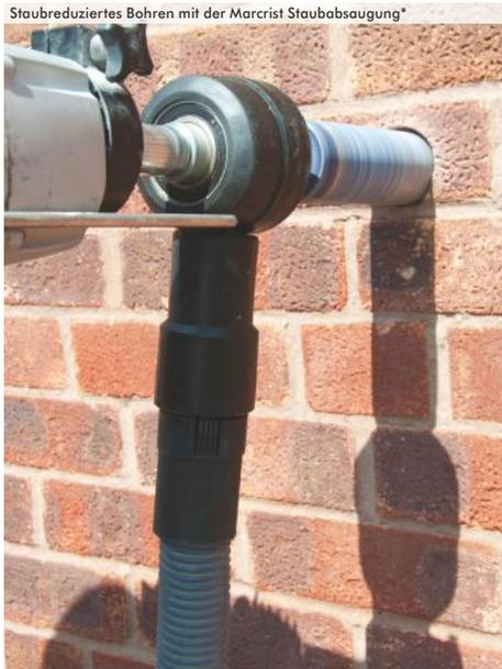
Staubreduziertes Bohren mit der Marcrist Staubabsaugung\*
