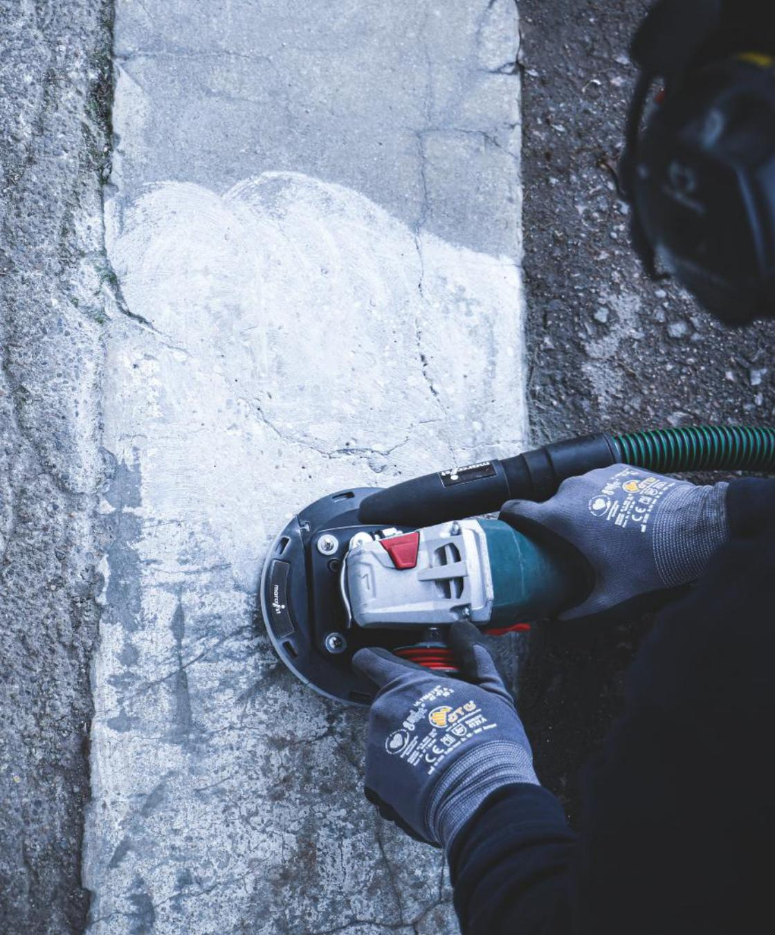
Schleiftöpfe für Betonschleifer
